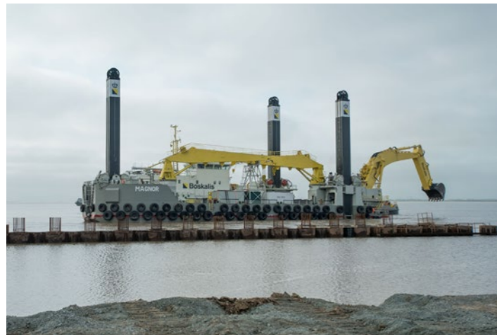
Backhoe Dredge 'Magnor'
